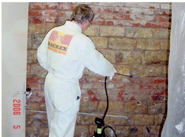
Napouštění opuky konzervačním prostředkem Anti Hydro.
