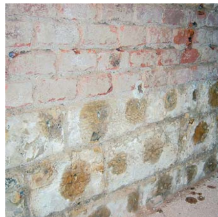
Stav po aplikaci injektážního krému, kdy se krém rozpustil
