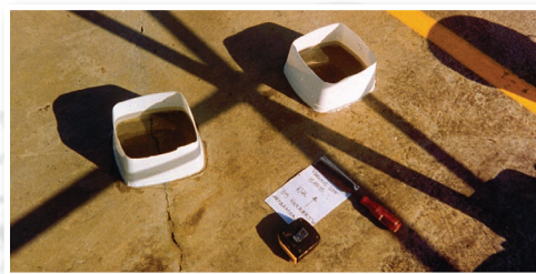
Vtková zkouška, prokazující účinnost RADCON Formula #7° přímo na stavbě
