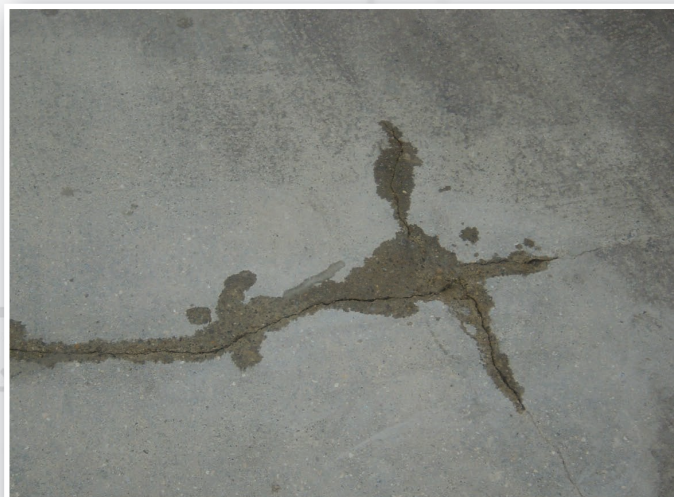
Utěsnění trhliny mycí rampy - vylití dutiny trhliny RADCONEM Formula #7®
