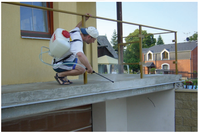
Hydroizolace terasy na RD v Liberci
