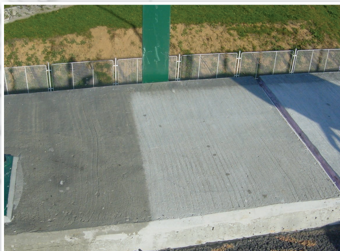
Povrch betonové římsy těsně po aplikaci RADCON Formula #7®
