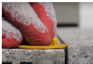
Vyrovnávací terčíky (0,5 mm, 1 mm, 2 mm, 3 mm)
